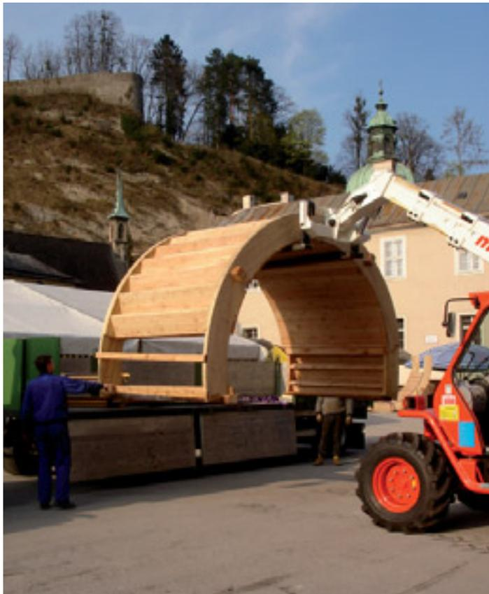
und ist aus Lärchenholz gefertigt. Eine Überdachung sollte die Haltbarkeit noch weiter erhöhen. Da der Zufluss in den Stiftsarm reguliert ist, können nach Fertigstellung kontinuierlich zirka 10 kW Ökostrom in das Netz gespeist werden. Der noch vorhandene Wasserbau der früheren Turbine konnte ohne Eingriffe in die historische Bausubstanz adaptiert werden.
